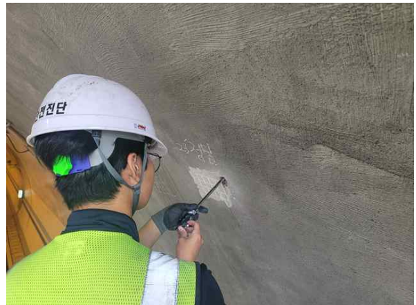
터널 라이닝 비파괴시험
