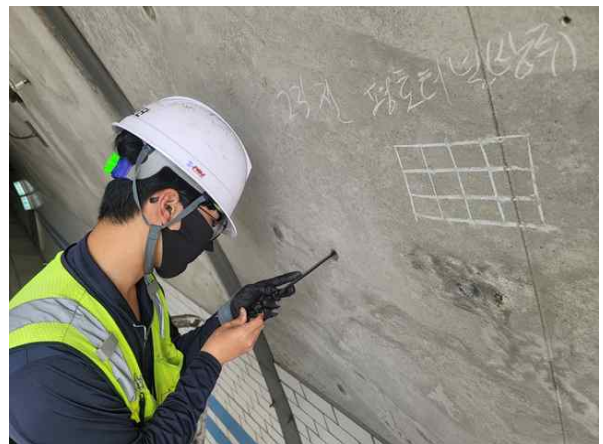
터널 라이닝 비파괴시험
