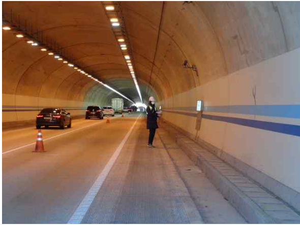
도보점검을 통한 근접조사
