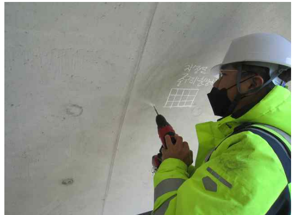
터널 라이닝 비파괴시험
