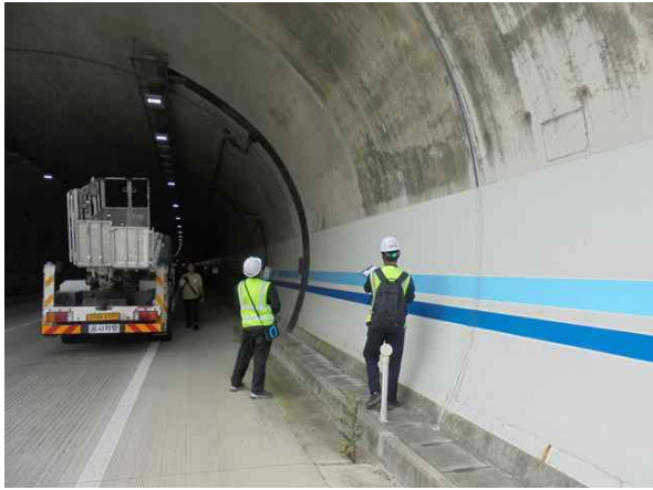
도보점검을 통한 근접조사
