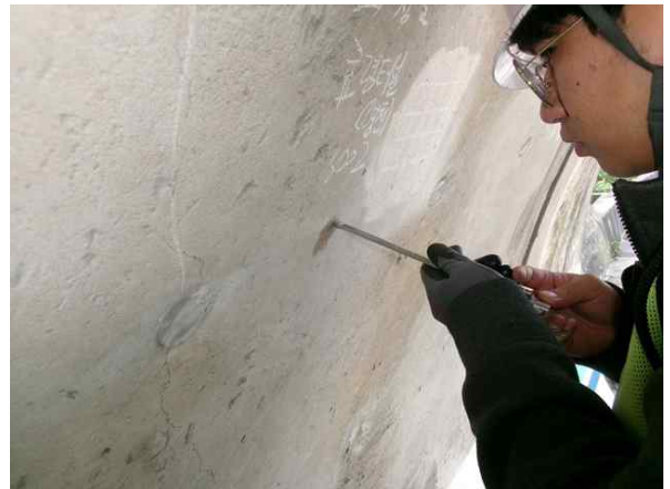
터널 라이닝 비파괴시험
