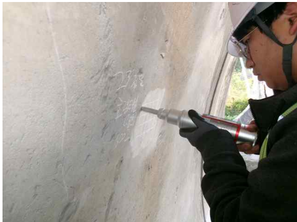
터널 라이닝 비파괴시험
