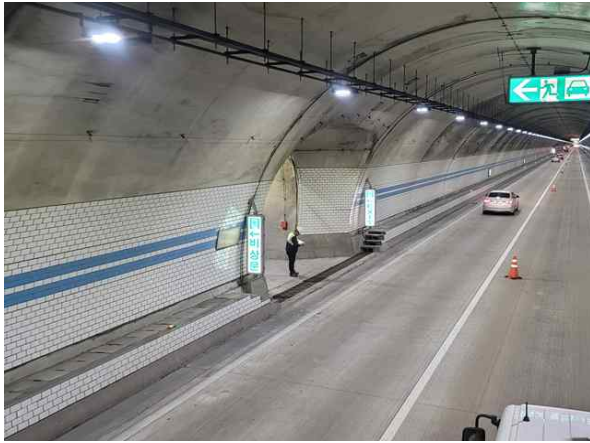
도보점검을 통한 근접조사
