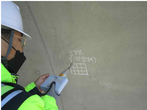
터널 라이닝 비파괴시험
