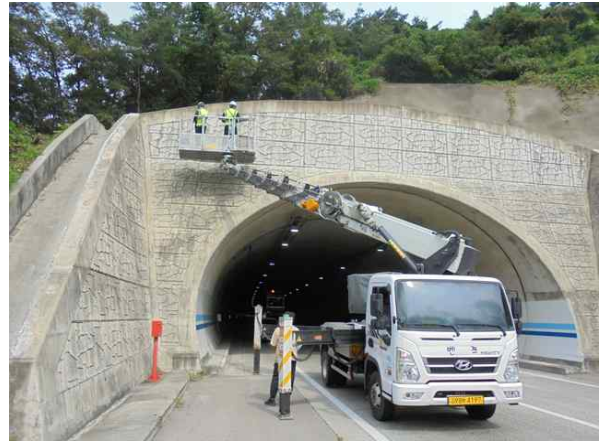
고소점검차를 이용한 근접조사
