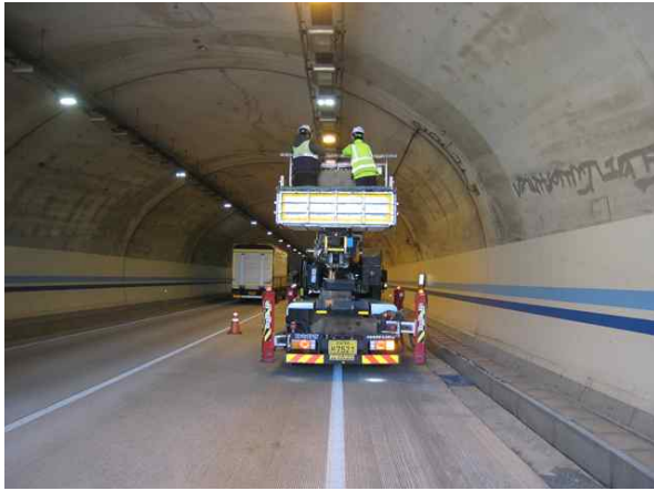
고소점검차를 이용한 근접조사
