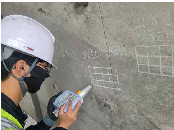
터널 라이닝 비파괴시험
