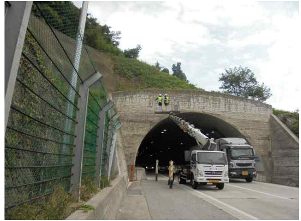
고소점검차를 이용한 근접조사
