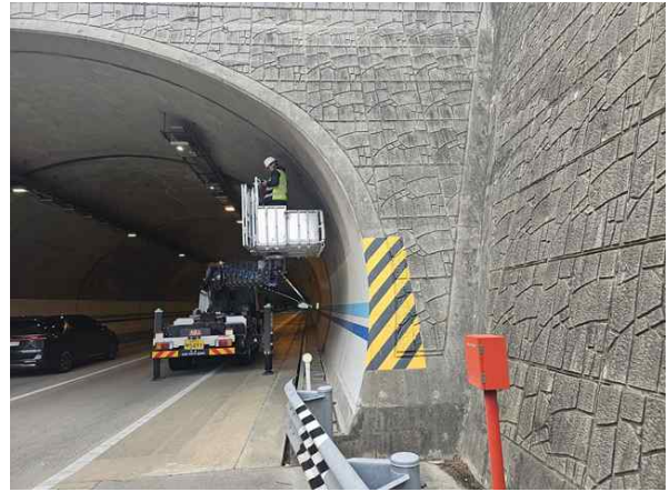
고소점검차를 이용한 근접조사
