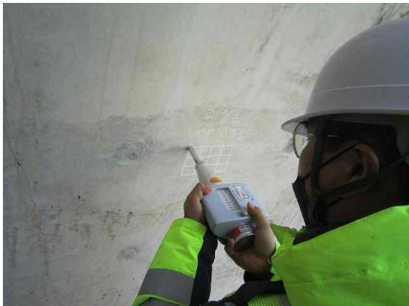
터널 라이닝 비파괴시험
