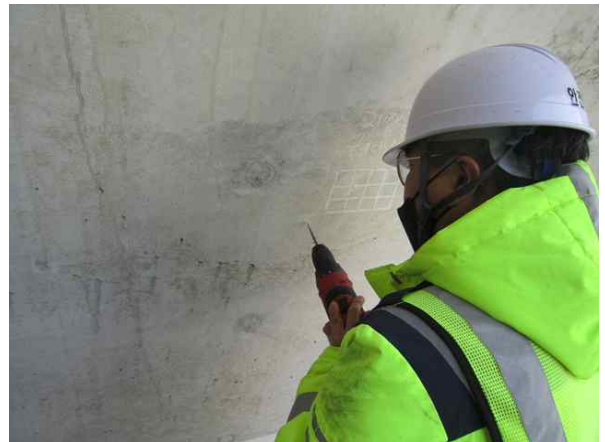
터널 라이닝 비파괴시험
