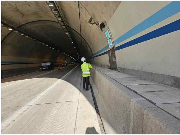
도보점검을 통한 근접조사
