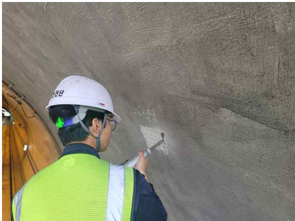
터널 라이닝 비파괴시험
