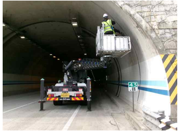
고소점검차를 이용한 근접조사
