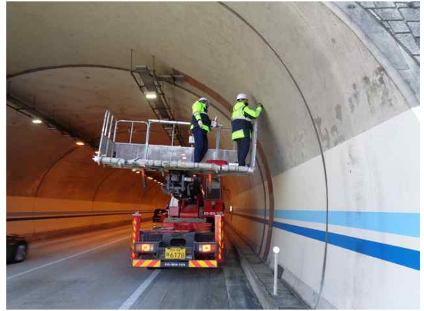
고소점검차를 이용한 근접조사
