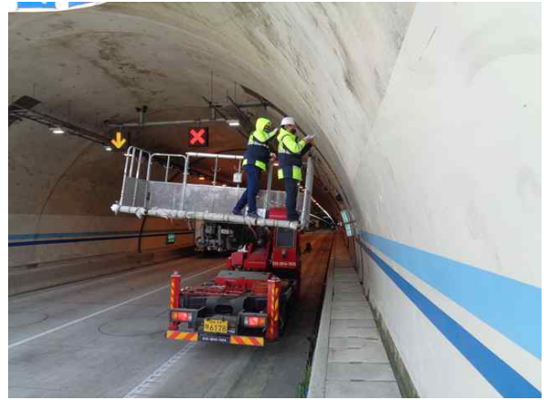
고소점검차를 이용한 근접조사
