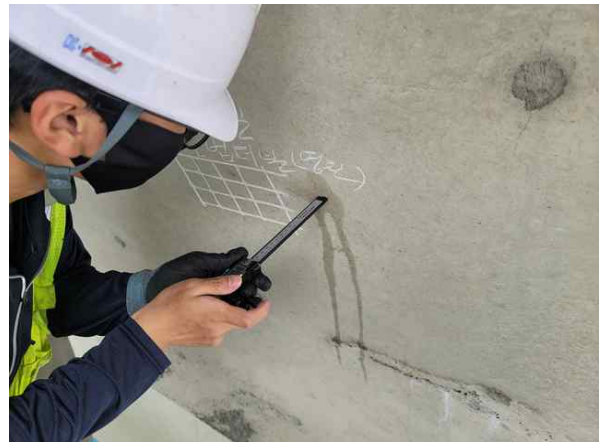
터널 라이닝 비파괴시험
